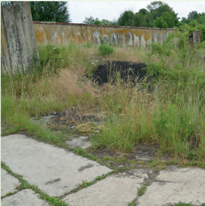
Aufwertung durch Abriss und Entsieglung einer großflächigen Siloanlage am Radweg als Kompensationsmaßnahme für den Radwegebau.
