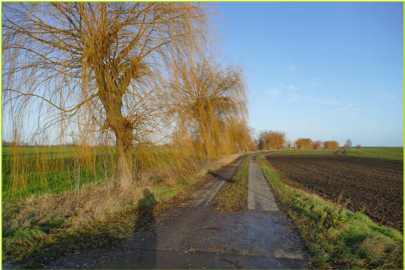
Abb. 114: Zustand 2019: Durch die Überschirmung des Weges war die Durchgängigkeit für landwirtschaftliche Maschinen nicht mehr gegeben, 10.12.2019
