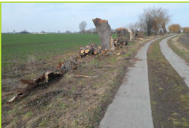
03.03.2021-Nach Abschluss der Schnittmaßnahmen
