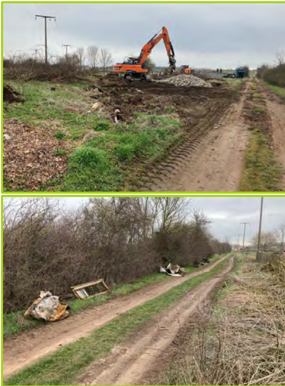
Abb. 97: Abriss des Fahrtilos im März 2023
