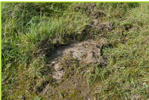
23.09.2021-Beton unter der Grasnarbe
