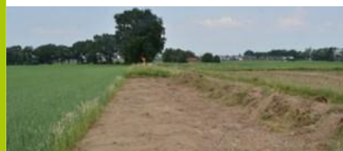
Oberbodenabtrag Quelle: Björn Rohloff
